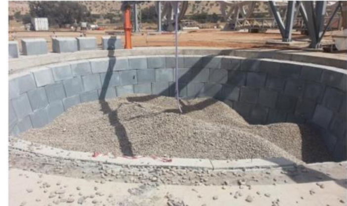
G. Zangahen, A. Pedretti, S.A. Zavattoni, M.C. Barbato, A. Haselbacher A. Steinfeld: Design of a 100 MWhth packed-bed thermal energy storage, Energy Procedia 49 (2014) 1071-1077
